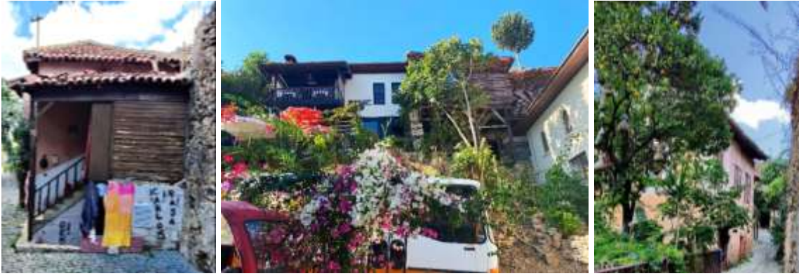
Şekil 5. Tophane Mahallesi Geleneksel ev örnekleri (2025)
