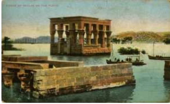
Görsel 17. Baraj Öncesi Philae Tapınağı
