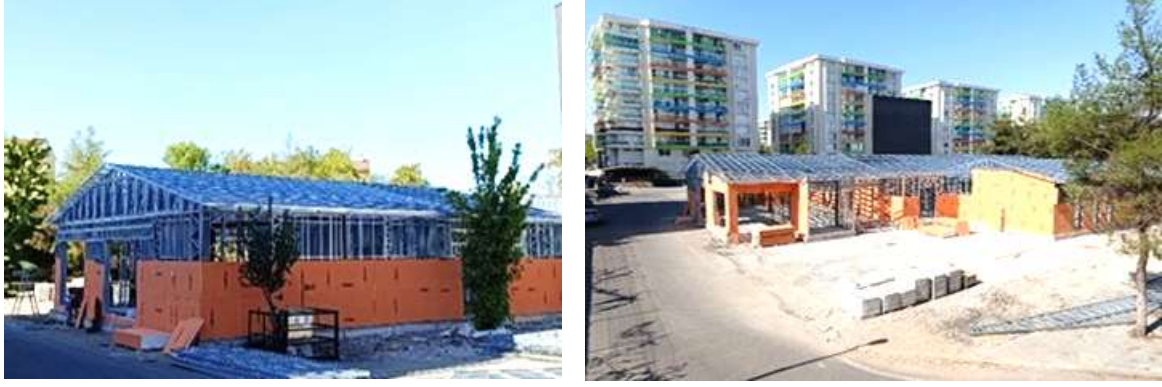
Şekil 8. Çelik panellere levhalar ile kaplama yapılması (Bekçi,2025)
