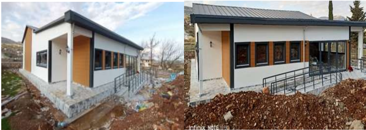
Şekil 12. Hafif çelik idari ofis binası örneği (Bekçi,2025)
