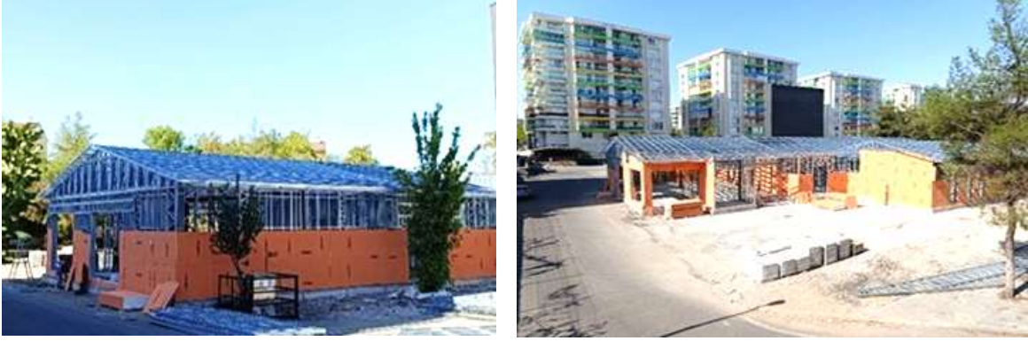
Şekil 8. Çelik panellere levhalar ile kaplama yapılması (Bekçi,2025)
