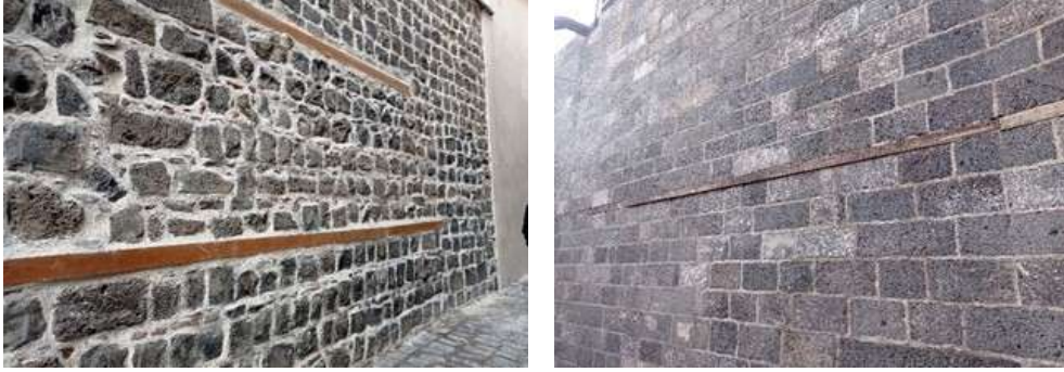
Şekil 3. Diyarbakır geleneksel evlerinde ahşabın hatıl olarak kullanımı (2025)
