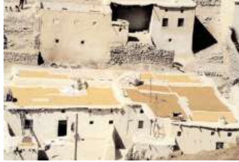
Görsel 1.1 Kerpiç malzemesi ile inşa edilmiş konaklama birimleri
