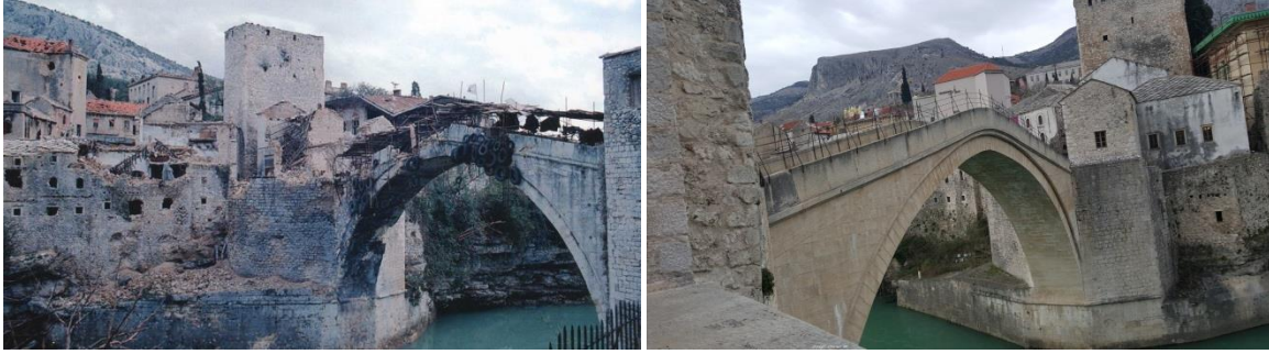
Şekil 7: Bosna-Hersek’te bulunan Mostar Köprüsü 1993 yılında savaş sırasında ağır hasar almıştır. (mepanews.com, 1993 – Kişisel Kaynak, 2016)
