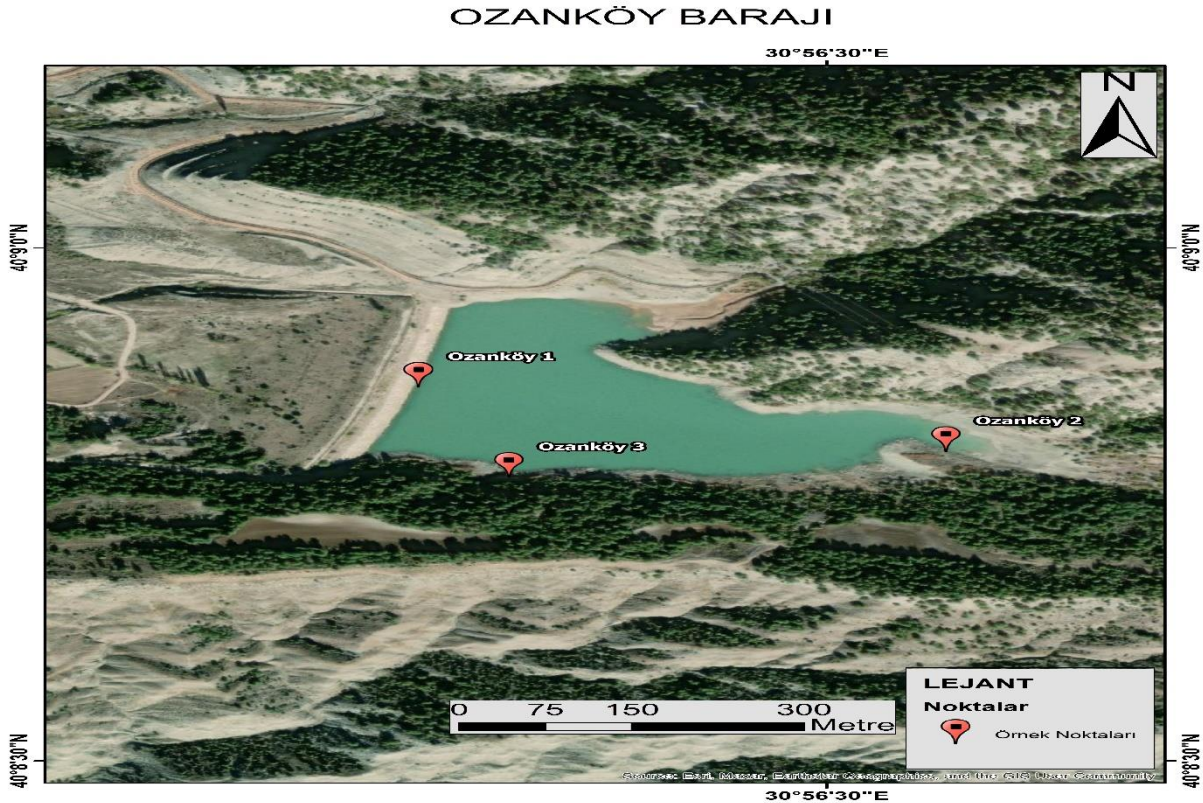
Şekil 1: Ozanköy Barajı Görüntüsü
