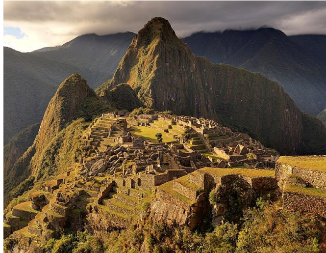
Şekil 10: Aşırı turist akınına maruz kalarak yapısal ve çevresel tahribata uğrayan Peru, Macchu Picchu kentinde yollar ve yapılar üzerindeki aşınmalar ciddi boyutlara ulaşmıştır. Çökme riski sebebiyle ziyaretçi sayısı sınırlı tutulmaktadır. ( www.telegraph.co.uk )
