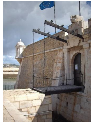
Görsel 4: Açılır-kapanır köprü
