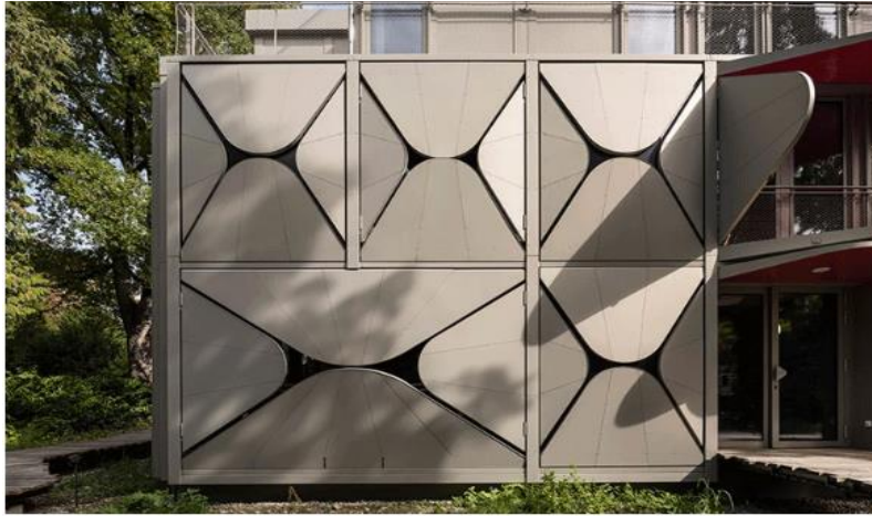
Görsel 7: Mekanik Bale Binası cephe kapakları kapalı iken görünüş (Url-1)
