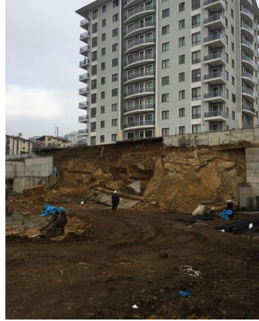
Şekil 5. Mohr-Clomb makaslama yenilmesine ait Konuralp ilçesinde Kayan (yenilen) Bina örneği (a), (b)
