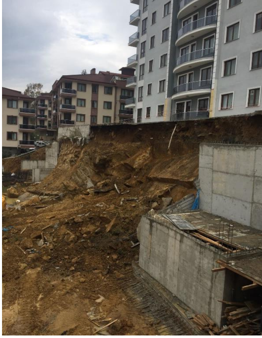
Şekil 5. Mohr-Clomb makaslama yenilmesine ait Konuralp ilçesinde Kayan (yenilen) Bina örneği (a), (b)
