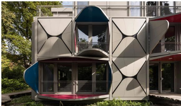
Görsel 8: Mekanik Bale Binası cephe kapakları açık iken görünüş (Url-2)
