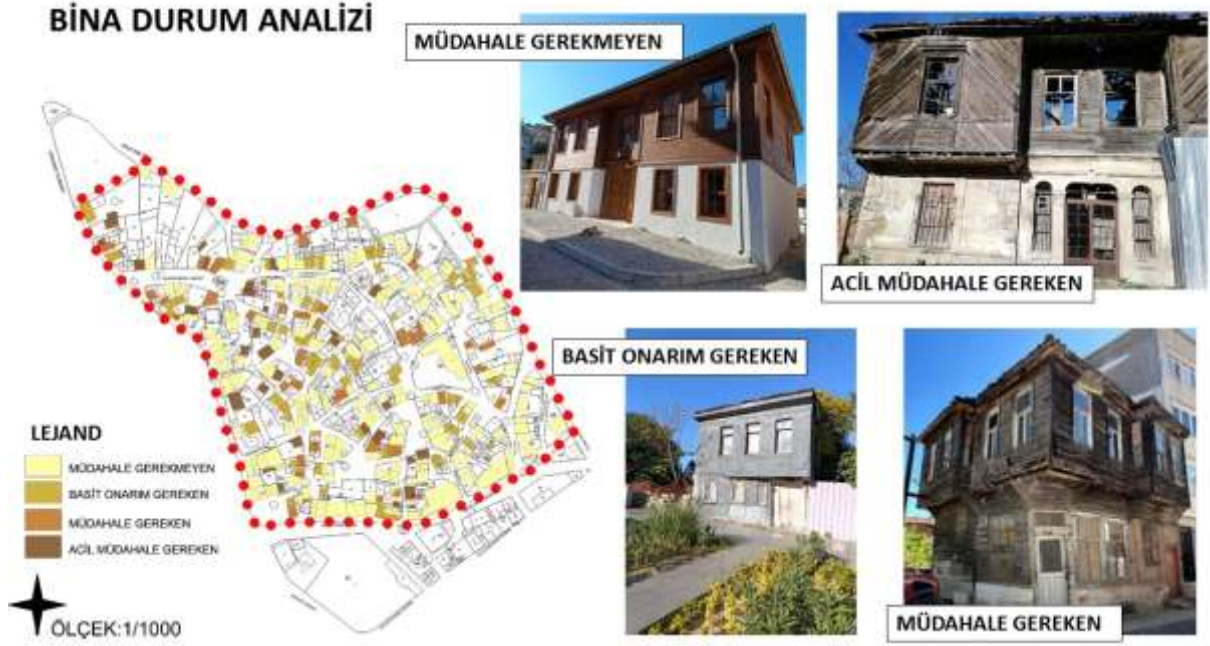
Şekil 6: Bina Durumu Analizi
