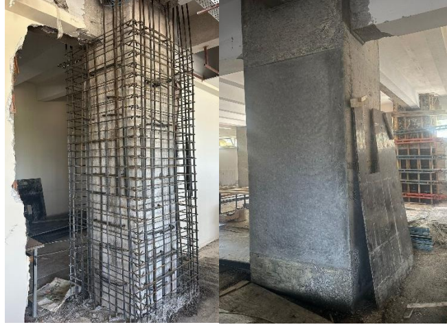
Şekil 4. Mimarlık Fakültesinde yapılan güçlendirme uygulamaları (2024)
