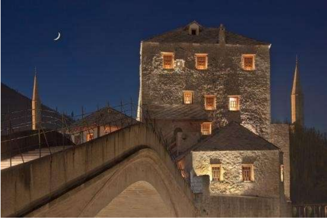
Yeniden inşa edilen Mostar Köprüsü
