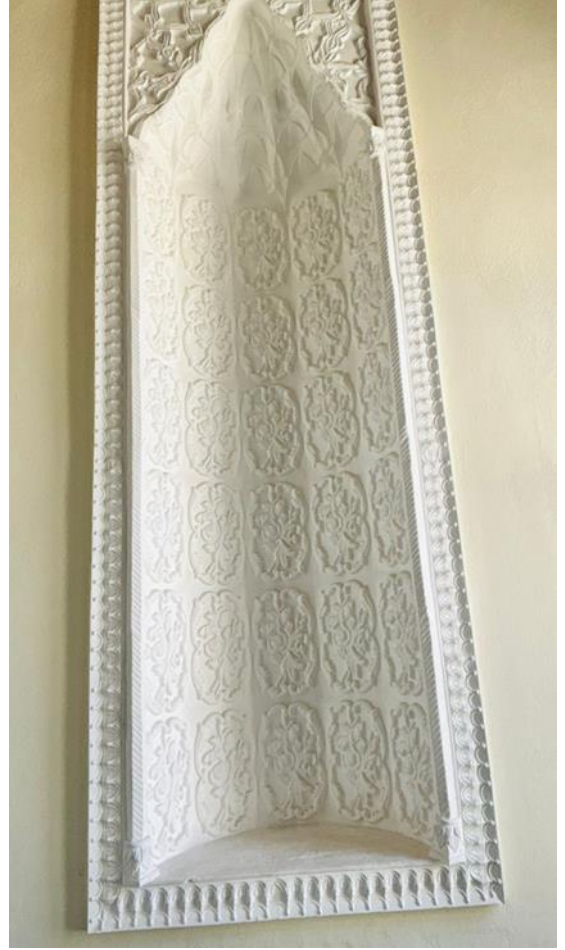
Görsel 10- kuzeyde yer alan odanın doğu duvarındaki
