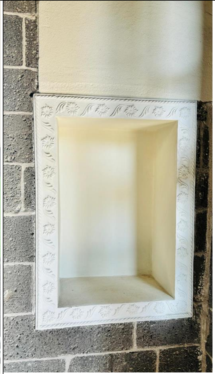
Görse14- Selamlıktan giriş sağladıktan sonra bu bölümde en kuzeyde yer alan odada batıdaki dolap nişi
