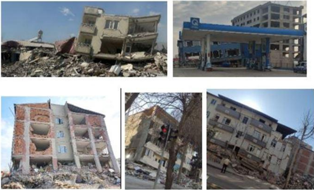
Şekil 2. Az katlı zemin kat dolgu duvarsız yapılarda görülen yumuşak kat düzensizlikleri
