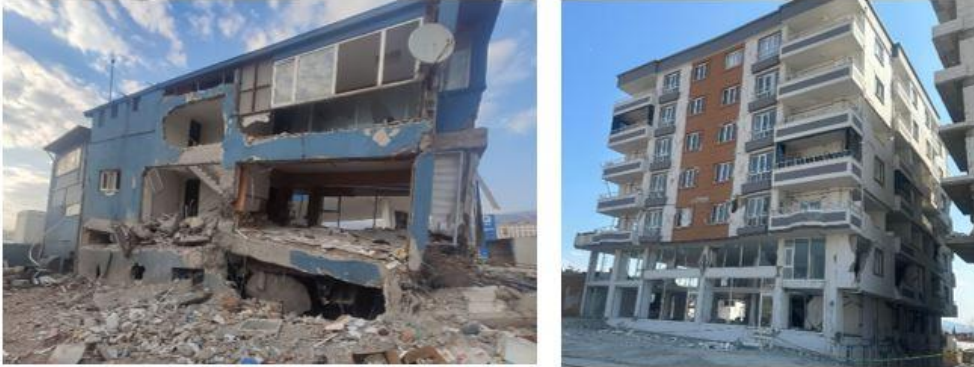
Şekil 4. Zemin katta oluşan yükseklik farkı ve dolgu duvarsız yüksek katlı binalarda oluşan yumuşak kat düzensizliği
