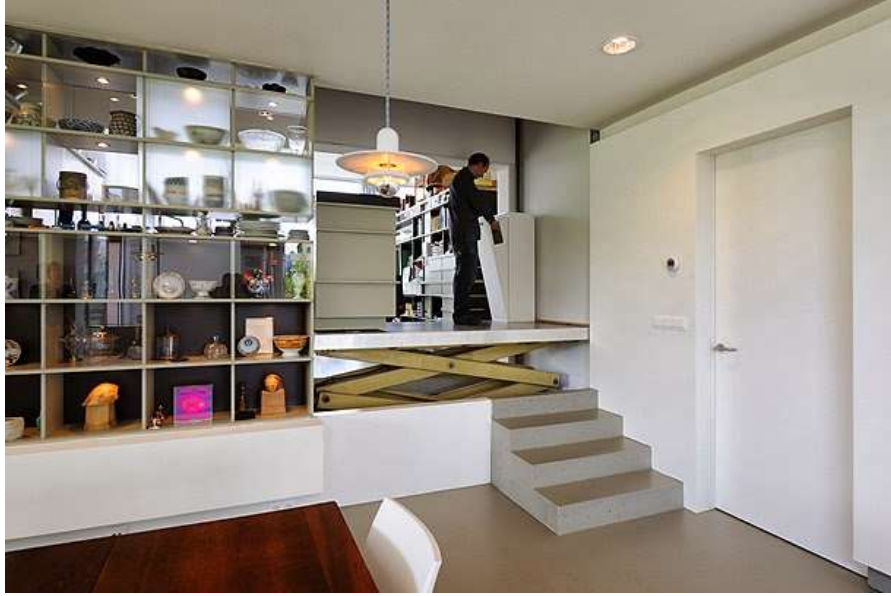
Şekil 10. Eşyaların taşınmasını sağlayan asansör sistemi
