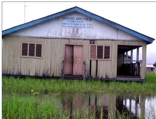
Photo 3 : La construction de la maison des jeunes pour les loisirs et les activités culturelles à Ganvié.
