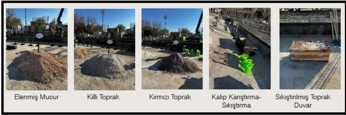
Şekil 4.14: Sazgın Ekolojik Köyü Deprem Sonrası Sıkıştırılmış Toprak İle İnşaa Tekniği Uygulamalı Gösterimi (Kaynak: Yazar)
