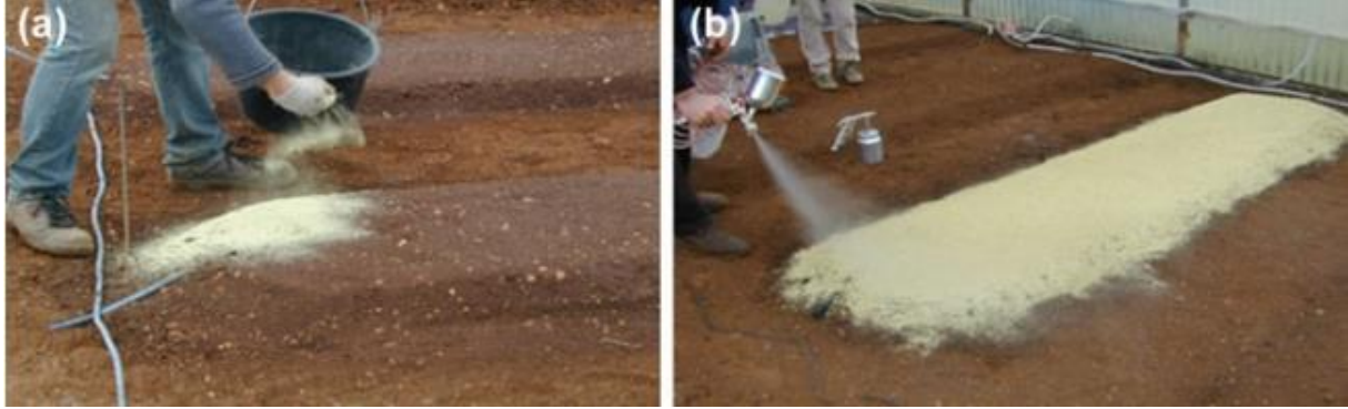
Şekil 2. (a) Toz karışımının serpilmesi; (b) Sodyum aljinat çözeltisi püskürtme (Santagata ve ark., 2017).
