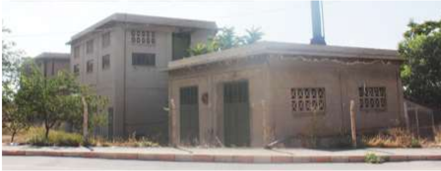
Şekil-2 Gülyağı tesislerinin fotoğrafı (Burdur Yeni Gün Gazetesi, 2019)
