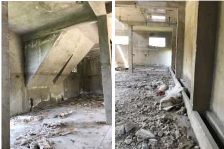
Şekil-11 Gülyacağı Üretim Binası İç Mekan Fotoğrafları (Yılmaz Özev, 2019)
