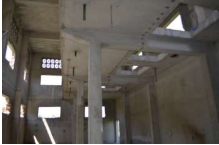
Şekil-10 Gülyacağı Üretim Binası İç Mekan Fotoğrafları (Yılmaz Özev, 2019)
