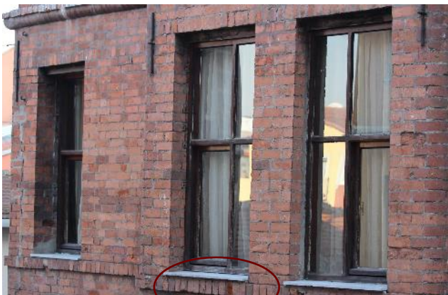
Şekil 2. Çevresel etkilere ve/veya tasarıma uygun olmayan bileşenlerin seçilmesine örnekler
