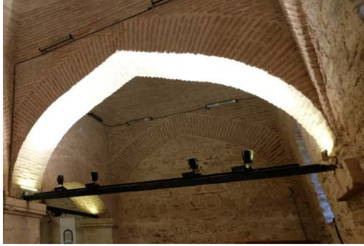
Şekil 2.1. Haseki İmaretindeki sivri kemerler
