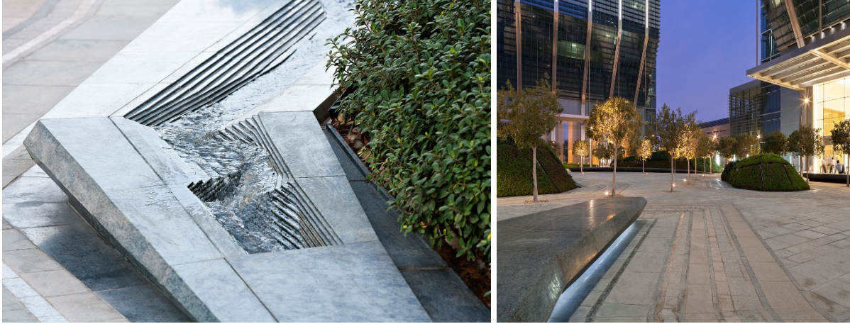
Şekil 3.4 Oturma birimlerinde yer alan Falaj Sistemi ve Aydınlatma Sistemi (Anonim 2021c).
