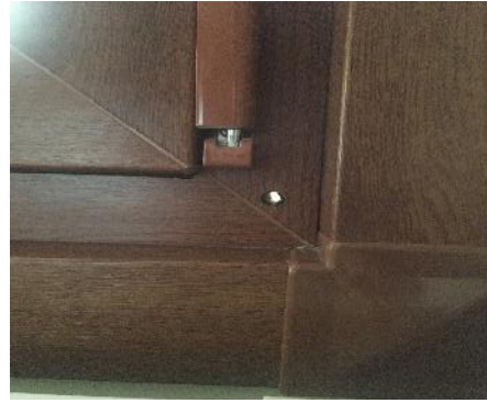
Şekil 5. Uzman görüşü almadan pencere bileşenleri üzerinde açılan boşluklara örnekler
