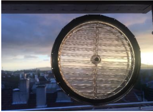
Şekil 5. Uzman görüşü almadan pencere bileşenleri üzerinde açılan boşluklara örnekler
