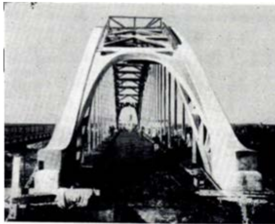
Şekil 2.9 Saint-Lucien Köprüsü, Tunus (Biometrics & 1959)
