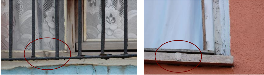
Şekil 3. Budak sorunu olan ahşap malzemelerin kullanıldığı pencere örnekleri
