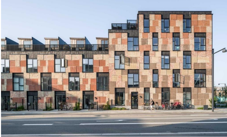
Fotoğraf 1: Terk edilmiş binaların atık ahşap parçalarını ve duvarlarını yeni cephe elemanları olarak kullanarak tasarlanan bina, Kopenhag (URL-1)
