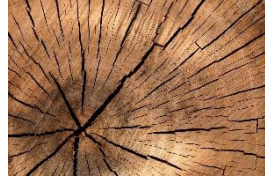
Görsel 8. Ahşap çatlağı (ustakunduz.com/)
