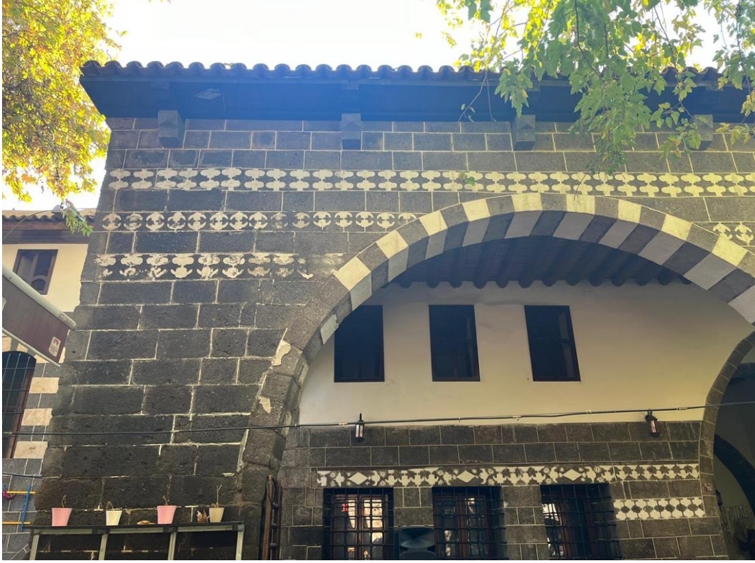
Görsel-20- İskender Paşa Konağının güneyinde avluya bakan eyvandan bir görünüm
