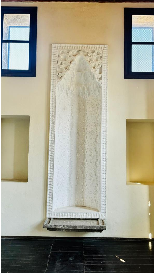
Görsel 5 Selamlığın eyvan bölümünden çıkılan üst katta batı duvarında bulunan mihrabiye formunda niş
