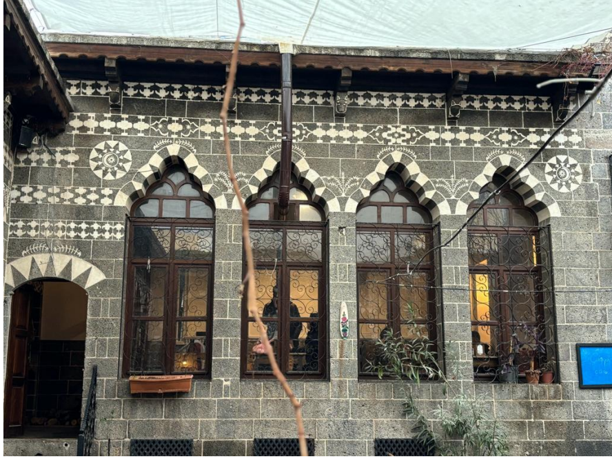
Görsel-28- 406 Ada 16 nolu parselin başodanın bulunduğu bölümünün dış cepheden görünümü
