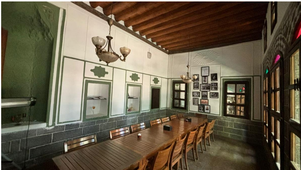
Görsel-21- İskender Paşa Konağının batıdaki başoda olarak değerlendirilen odanın dolap nişleri
