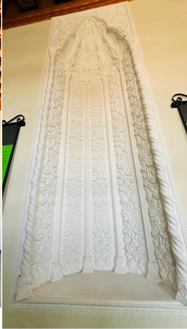
Görsel 8 -Kuzeyde yer alan odanın kuzey duvarında mihrabiye formunda Niş detayı
