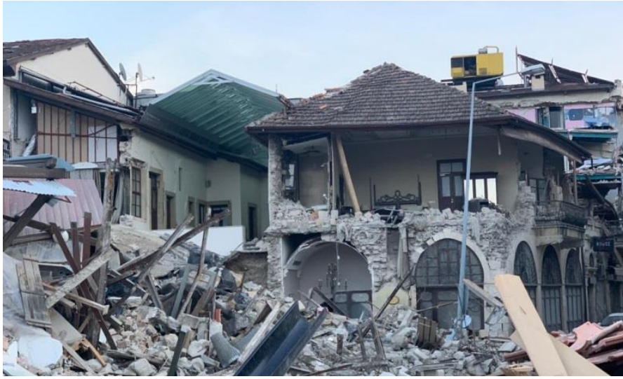
Şekil 2: 6 Şubat depremlerinde Türkiye’de ve Suriye’de birçok doğa ve kültür varlığı ağır hasar almış ve yıkılmıştır. (Antakya’da yıkılan sivil mimarlık örneği, kişisel arşiv, 2024)
