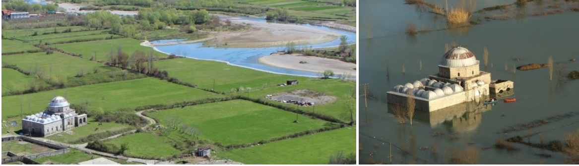
Şekil 4: İşkodra Kurşunlu Camii, yakınında bulunan nehrin artan yağış rejimleri ile taşması sonucu yılın belli dönemlerinde su altında kalmaktadır. Bunun sonucunda minaresi yıkılmıştır ve yapısal malzemelerinde bozulmalar görülmektedir. (Kişisel Arşiv, 2015 – Anadolu Ajansı, 2022)
