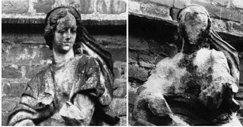
Şekil 6: Almanya'nın Vestfalya kentindeki kalenin portalı üzerinde bulunan kumtaşı heykel, asit yağmurları sebebi ile 60 yıl içinde erimiştir. (Herr Schmidt-Thomsen, 1908-1968)
