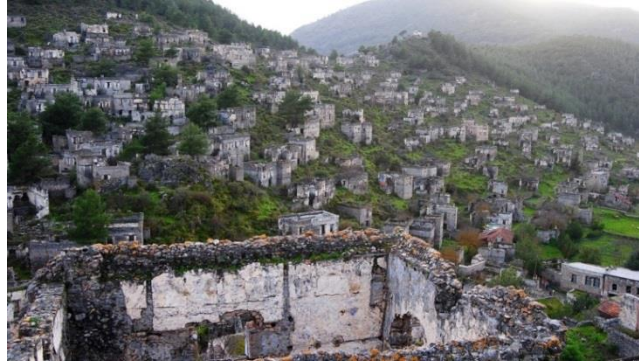
Şekil 9: 1923 yılında gerçekleşen mübadelede boşaltılan Muğla Kayaköy'e göçmen nüfus getirilerek yerleştirilmiştir. Bir süre sonra köyde yaşayan nüfus azalmış, 1957 Fethiye Depreminde köyün ağır hasar almasıyla da köy terk edilmiştir. (Erkan Ceylan, 2022)
