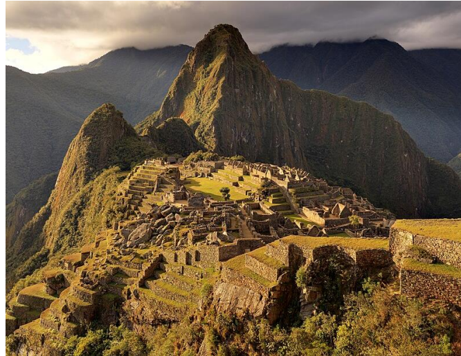
Şekil 10: Aşırı turist akınına maruz kalarak yapısal ve çevresel tahribata uğrayan Peru, Macchu Picchu kentinde yollar ve yapılar üzerindeki aşınmalar ciddi boyutlara ulaşmıştır. Çökme riski sebebiyle ziyaretçi sayısı sınırlı tutulmaktadır. ( www.telegraph.co.uk )
