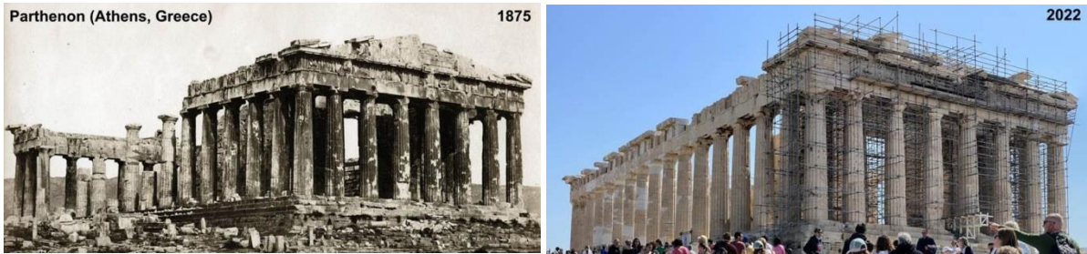
Şekil 12: Atina Parthenon Tapınağı'nda 19. yüzyılın sonlarında ve 20. yüzyılın başlarında yapılan müdahaleler sırasında kullanılan demir kenetler zamanla paslanarak mermer bloklarda çatlaklara ve kırılmalara yol açmıştır. Bu sorunlar, daha sonra yapılan restorasyon çalışmalarıyla giderilmeye çalışılsa da orijinal yapı üzerinde kalıcı hasarlar bırakmıştır. (commons.wikimedia.org)
