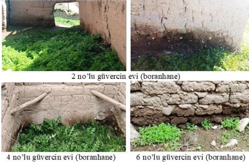
Şekil 3.7. Güvercin Evlerinde (Boranhane) meydana gelen bitki oluşumları
