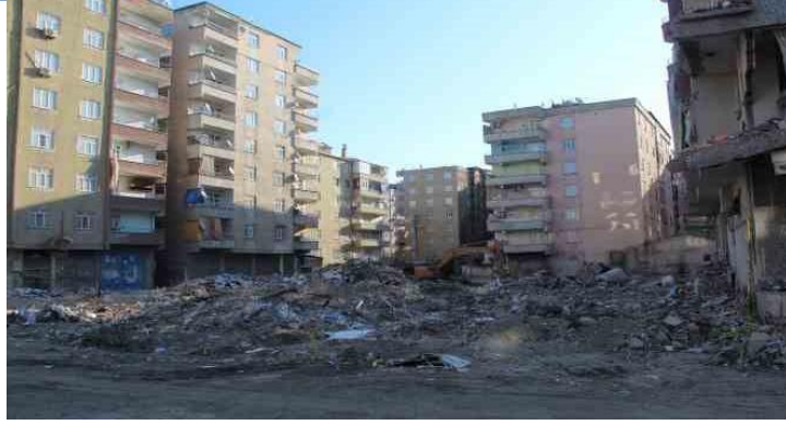
Şekil 2.6. Bağlar ilçesinde yıkılan Yoldaş Apartmanının deprem sonrası durumu (URL 3)
