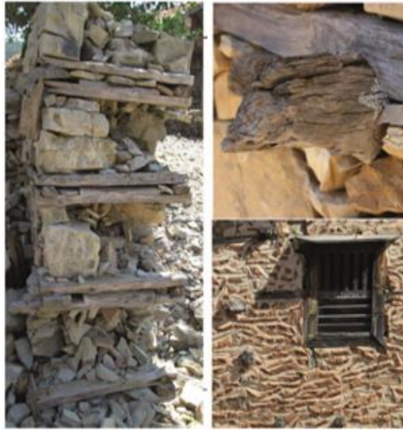
Figure 6: Section of the Dry-Stone Wall (Karayazı & Sağiroğlu, 2016).
