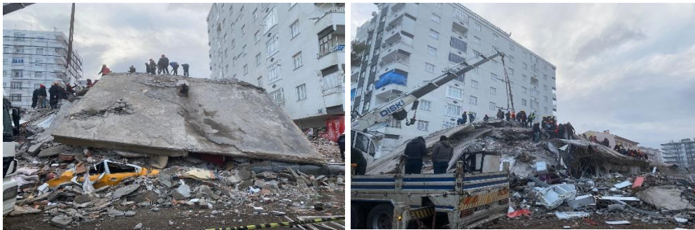
Şekil 2.3. Bağlar ilçesinde yıkılan Hisami Apartmanının deprem sonrası durumu( 2023)
