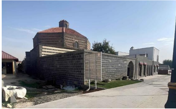
Şekil-8. Behram Paşa Hamamı Kuzeybatı Cephesi
