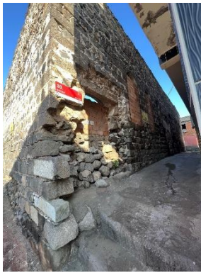
Şekil 3.7 Kuzey cepheden görünüm
