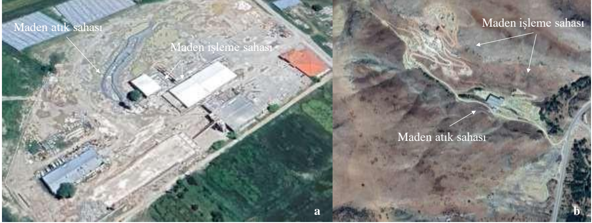
Şekil 1. Çimento üretiminde kullanılan maden atıklarının işleme tesisleri ve atık depolama alanlarının yeri. (a) Andezit maden işleme sahası, (b) Olivin maden işleme sahası
