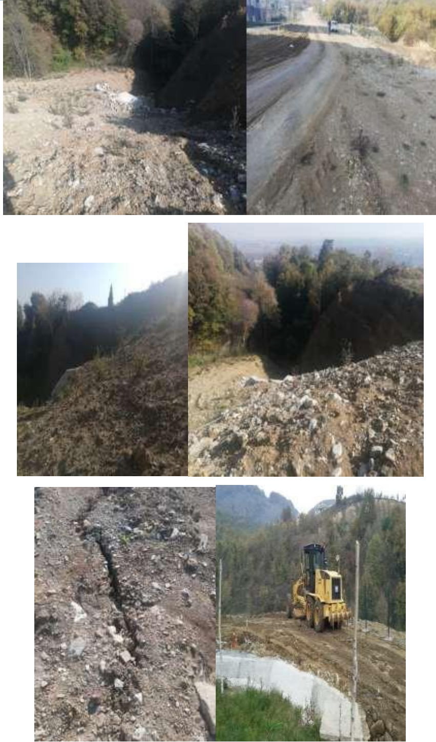
Şekil 3. Çalışma Alanından Görünüm
