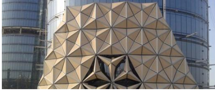
Görsel 10: Al Bahar Kuleleri dinamik cephesinin açık ve kapalı halinin görünüşü (Url-2)
