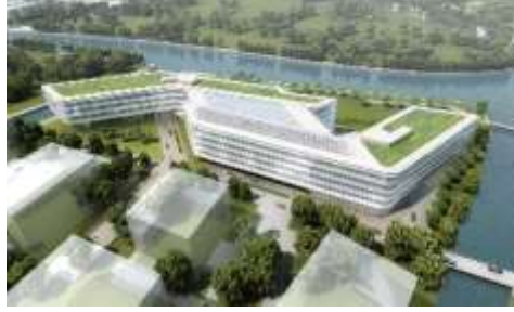
Şekil 2. Glumac Ofis Binası dış cephe görseli (URL-3, 2024)
