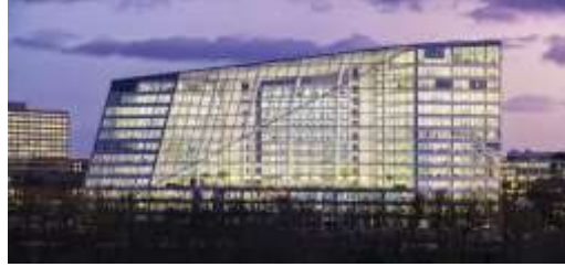
Şekil 4. The Edge Amsterdam Ofis Binası dış cephe görselleri
