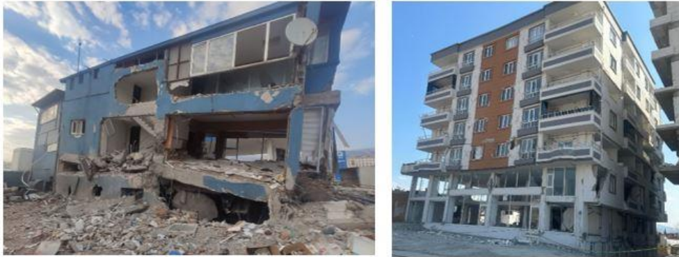
Şekil 4. Zemin katta oluşan yükseklik farkı ve dolgu duvarsız yüksek katlı binalarda oluşan yumuşak kat düzensizliği
