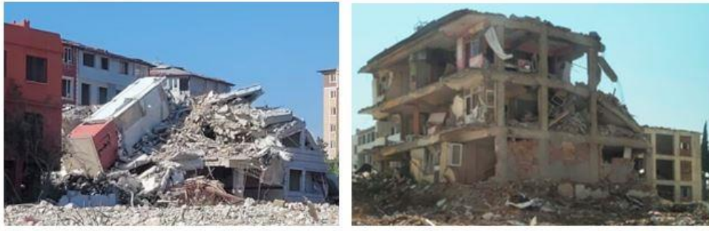
Şekil 6. Rijitlik farkı ile üst katlarda görülen yumuşak kat düzensizlikleri
