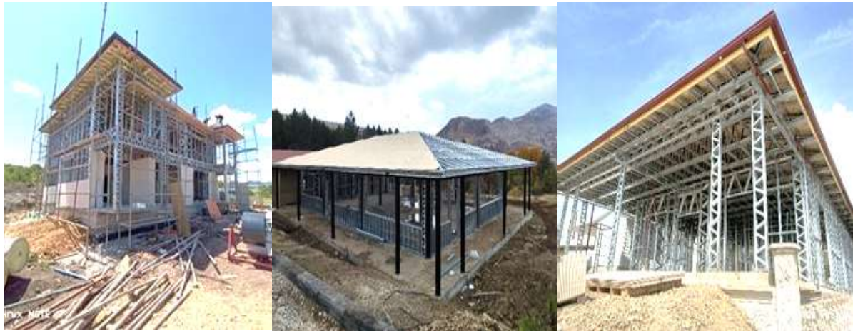
Şekil 10. Çatı makasları ve kaplamalarının yapıldığı yapı örnekleri (Bekçi,2025)
