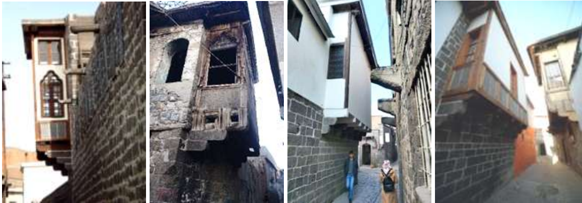
Şekil 6. Geleneksel evlerde saçaklarda ahşap detaylar
