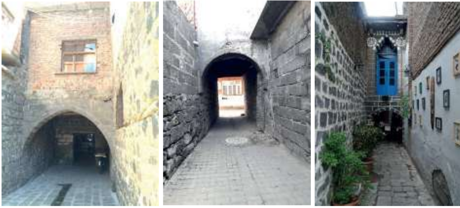
Şekil 7. Diyarbakir sokaklarında ahşap kirişlerle taşıtılan “kabaltı” örnekleri (Işık, 2024)
