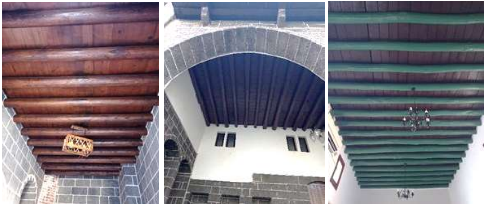
Şekil 4. Diyarbakır geleneksel evlerinde döşemelerde ahşap kiriş kullanım örnekleri (2025)
