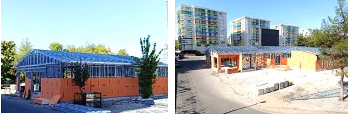
Şekil 8. Çelik panellere levhalar ile kaplama yapılması (Bekçi,2025)
