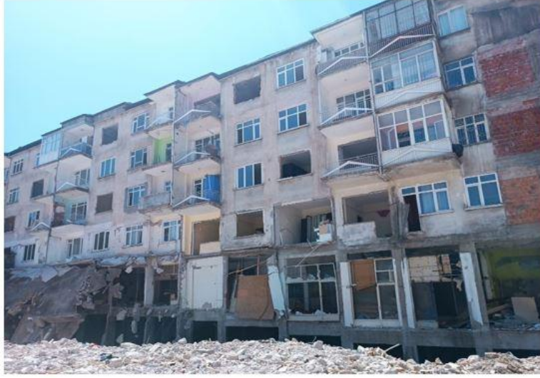
Şekil 4. Zemin katta oluşan yükseklik farkı ve dolgu duvarsız yüksek katlı binalarda oluşan yumuşak kat düzensizliği
