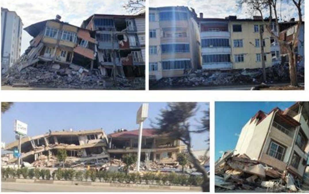
Şekil 3. Az katlı zemin kat dolgu duvarsız yapılarda görülen yumuşak kat düzensizlikleri
